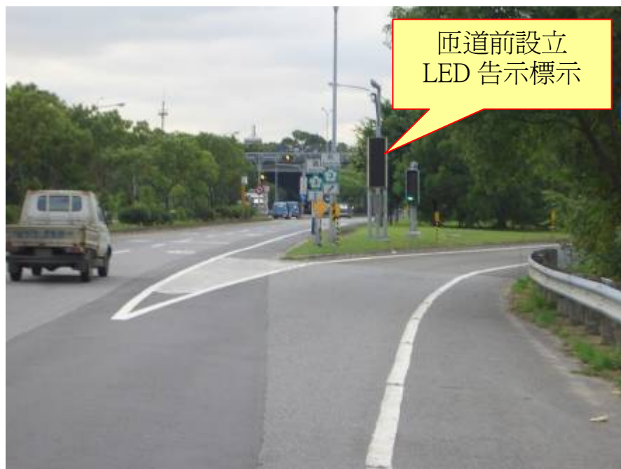
圖 4-3 平面道路進入匝道前設立 LED 告示標示
