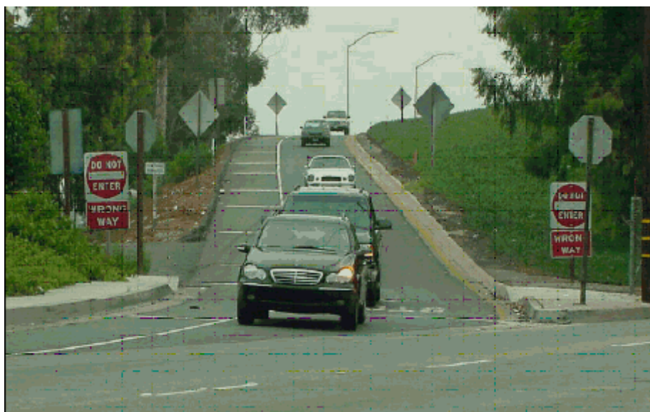
圖 2-4 加州高速公路出口匝道較低的「DO NOT ENTER」、「WRONG WAY」標誌 (圖片來源：Scott A. Cooner etl., 2004)
