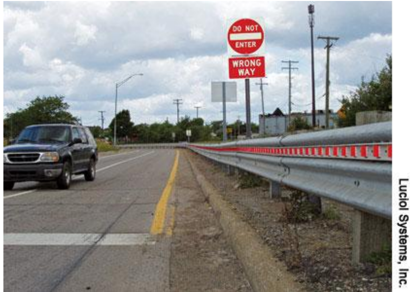
圖 2-9 出口匝道護欄裝設紅色反光標鈕
